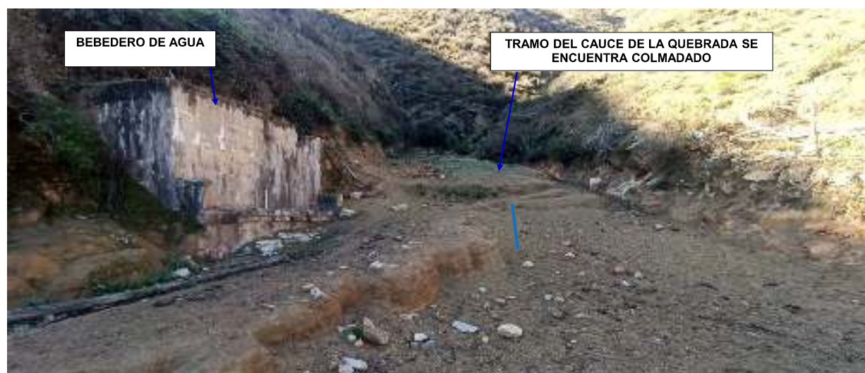
FIGURA N°02: CAUCE COLMATADO PRINCIPALMENTE DE ARENA CON PRESENCIA DE ROCAS DE DIFERENTES TAMAÑOS, SECTOR LLERHUANCA SAN JOSÉ, AFECTANDO A LA TROCHA CARROZABLE.
